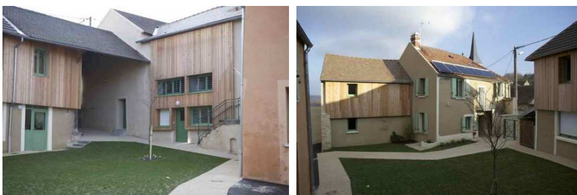
Réhabilitation d'une ancienne ferme en logements locatifs sociaux à Guerville
